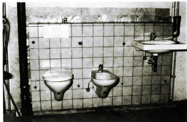
Bild 2: Körperschallisolierende Maßnahmen an einer Vorwand-Installation
