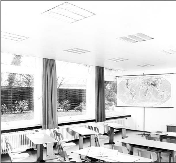
Bild 3: Photographische Aufnahme der neuen Akustik-Decke - die Mikro-Perforation ist kaum sichtbar
