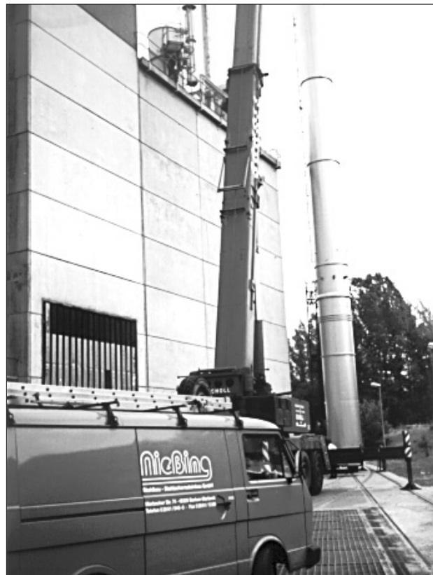
Bild 4: Photographische Aufnahme des Einbaus. Der obere Kamin-teil bis zum Anschlußteil hängt am Haken.
