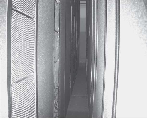
Bild 2: Fotografische Aufnahme eines Kulissenspaltes mit aktiven Absorberkassetten hinter Lochblech
