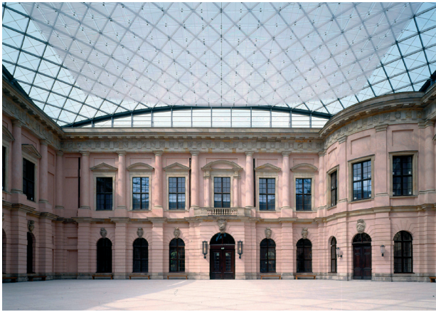
Bild 3: Transparentes Segel aus mikroperforierter Folie unter der neuen, konkav gewölbten Glasdach-Konstruktion im Schlüterhof.
