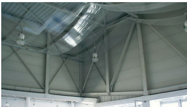
Bild 1: Frei abgehängte Bahnen mikroperforierter Folien im Forum des OIC.
