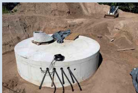
Abb. 11: Der Eisspeicher in der Bauphase Foto: Ingenieurbüro Willhaug
