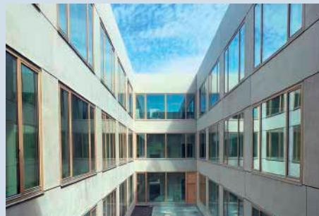
Abb. 79: Einblick in den schmalen Innenhof Foto: SPREEN ARCHITEKTEN
