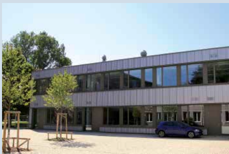
Abb. 42: Nordseite des Neubaus und Pausenhof Foto: Stadt Kaufbeuren
