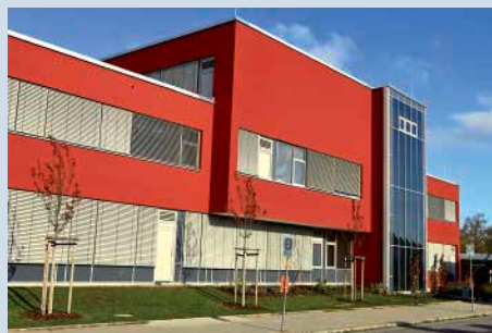
Abb. 19: Teilansicht der Gebäude-Südseite Foto: Winkler-Architekten
