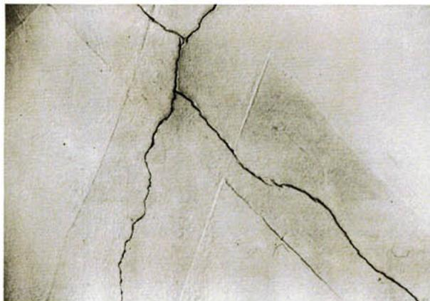
Durch Wärmespannungen entstandene Risse in der Betonaußenschale einer Sandwich-Konstruktion traten nach Beschichtung mit streifenweiser Armierung (Glasvliesgewebe) bald wieder in Erscheinung. Die Rißbewegung war zu groß, um dauerhaft überbrückt werden zu können.
