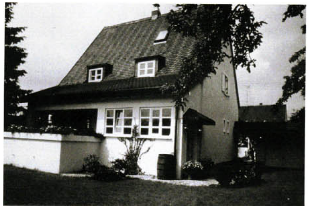
Bild 1: Ansicht des untersuchten Gebäudes nach Durchführung der Wärmedämmmaßnahmen
