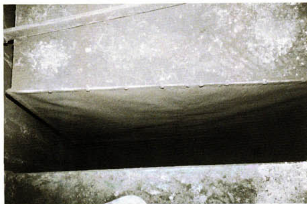
Bild 4: Membran-Absorber-Schalldämpfer im Rauchgaskanal
