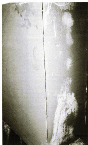
Bild 4: Membran-Absorber-Schalldämpfer im Rauchgaskanal
