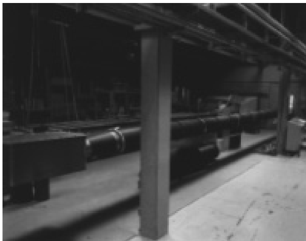
Bild 1: Rohr Schalldämpfer-Prüfstand mit eingebautem Schalldämpfer
