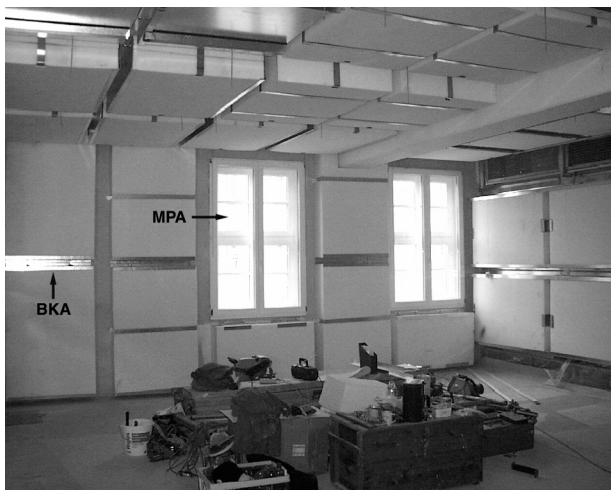
Bild 1: Foto des Tonnachbearbeitungsraumes mit Angabe der Absorberverteilung.
