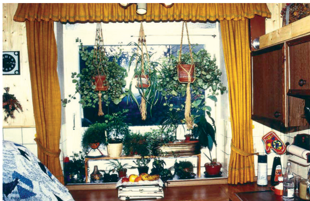
Bild 1: Eine ausreichende Lüftung kann hier nur über undichte Fensterfugen oder eine zusätzliche Lüftungseinrichtung erfolgen.
