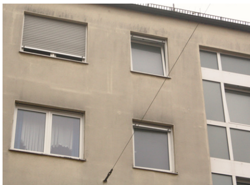
Ausschnitte der Nordfassade von Objekt 51, im Vergleich: 2014 (links) und 2022 (rechts), dort sind deutliche Ablaufspuren und helle Stellen entlang der Plattenstöße des WDV erkennbar. Der farbliche Unterschied der Fassaden ist durch unterschiedliche Aufnahmetechnik bedingt.
