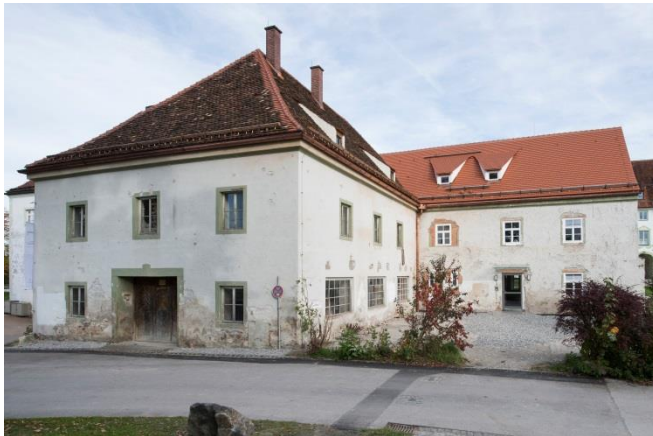
Die Alte Schäferei im Jahr 2010 vor der Sanierung © Fraunhofer IBP
