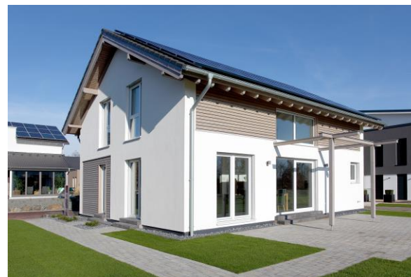
Süd-Ansicht Effizienzhaus Plus
