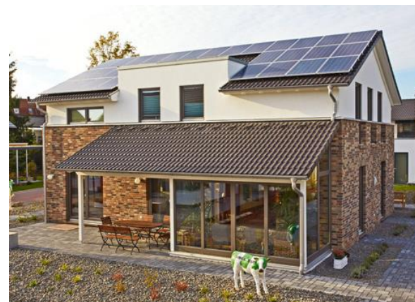
Südost-Ansicht Effizienzhaus Plus Isabella
