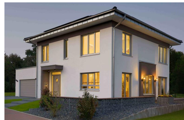
Süd Ansicht Effizienzhaus Plus Potsdam
