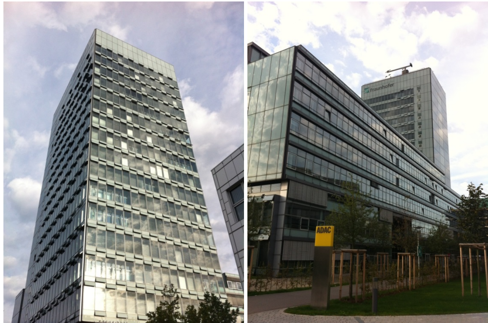
Bild 1: Hochhausbereich des Fraunhofer Hauses (linkes Foto: zu erkennen sind die geöffneten, je Etage unten und oben versetzt angeordneten Lüftungsklappen) und Nordflügel (rechtes Foto).
