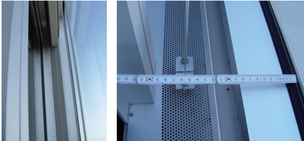
Bild 8: Blick in den Fassadenzwischenraum der Glasdoppelfassade, linkes Foto: Blick nach oben mit Lamellenraffstore; rechtes Foto: Blick auf die Brüstung.
