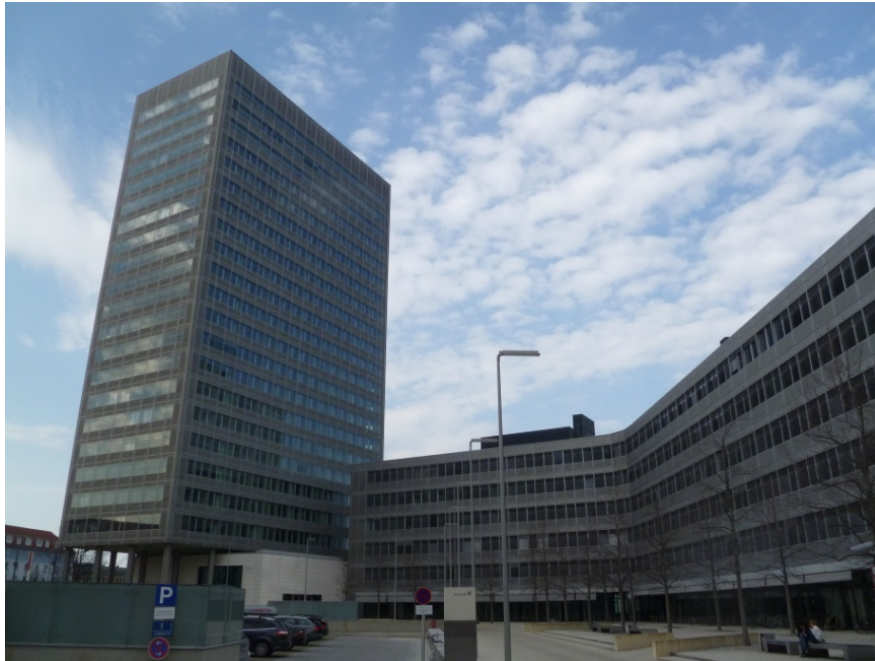
Bild 7: Fotografische Ansicht des Untersuchungsgebäudes Münchner Tor.
