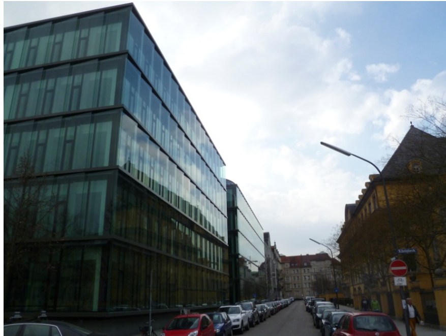
Bild 3: Fotografische Ansicht des Untersuchungsgebäudes Gedonstraße.
