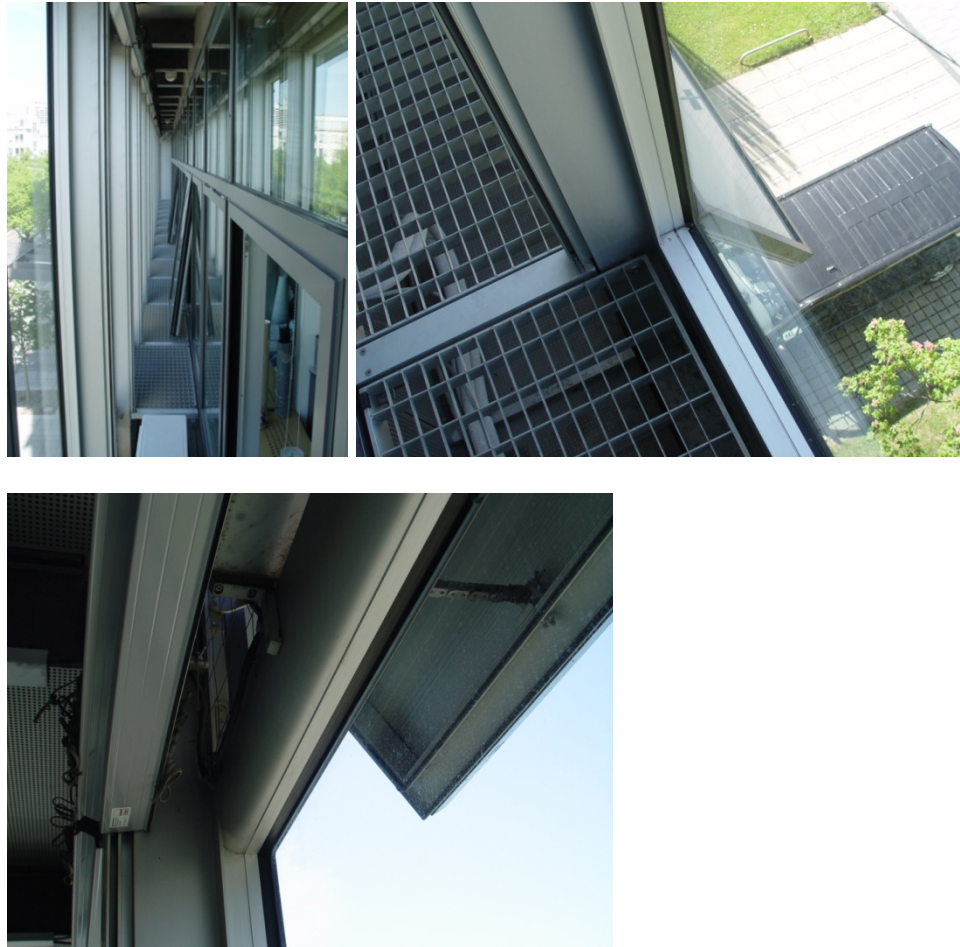
Bild 2: Blick in den Fassadenzwischenraum der Glasdoppelfassade, Foto oben links: gerader Blick in den Fassadenzwischenraum; Foto oben rechts: Blick nach unten mit ausgesetzter Lüftungsklappe; Foto unten: Blick nach oben mit ausgesetzter Lüftungsklappe und Lamellenraffstore.
