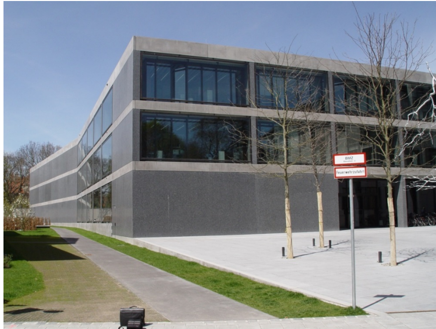
Bild 5: Fotografische Ansicht des Untersuchungsgebäudes Mandlstraße.
