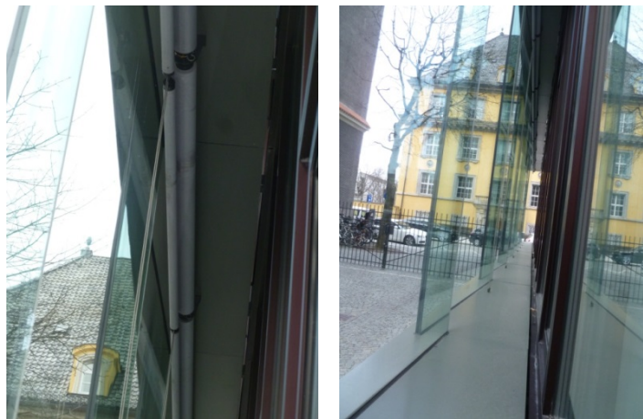
Bild 4: Blick in den Fassadenzwischenraum der Glasdoppelfassade, oberes Foto: Blick auf den Boden; unteres Foto links: Blick nach oben zum Textilrollo; .unteres Foto rechts: Blick geradeaus in den Fassadenzwischenraum.
