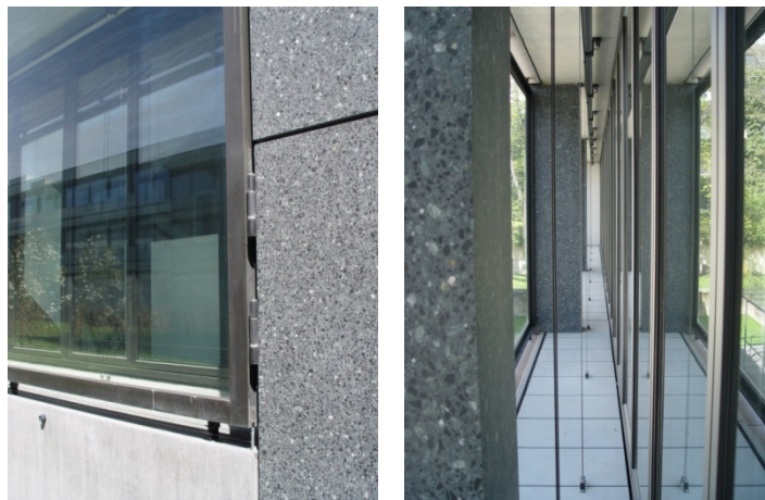
Bild 6: Blick in den Fassadenzwischenraum der Glasdoppelfassade, oberes Foto: Blick nach oben mit Textilrollo; unteres Foto links: Blick auf die GDF von außen; unteres Foto rechts: gerader Blick in den Fassadenzwischenraum.
