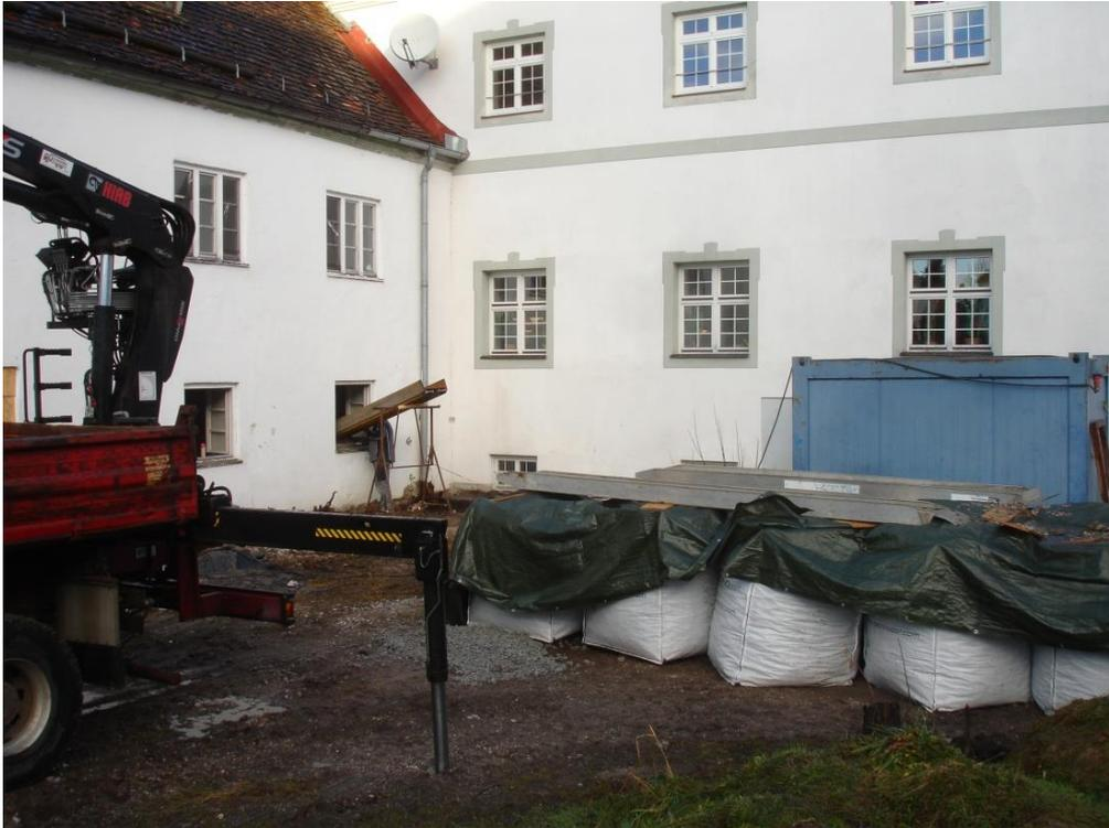
Bigbags, LKW mit Kran und Schütte zum Einbringen des Granulates über die Fenster.
