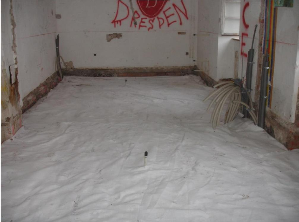
Komplette Abdeckung mit Geotextil.
