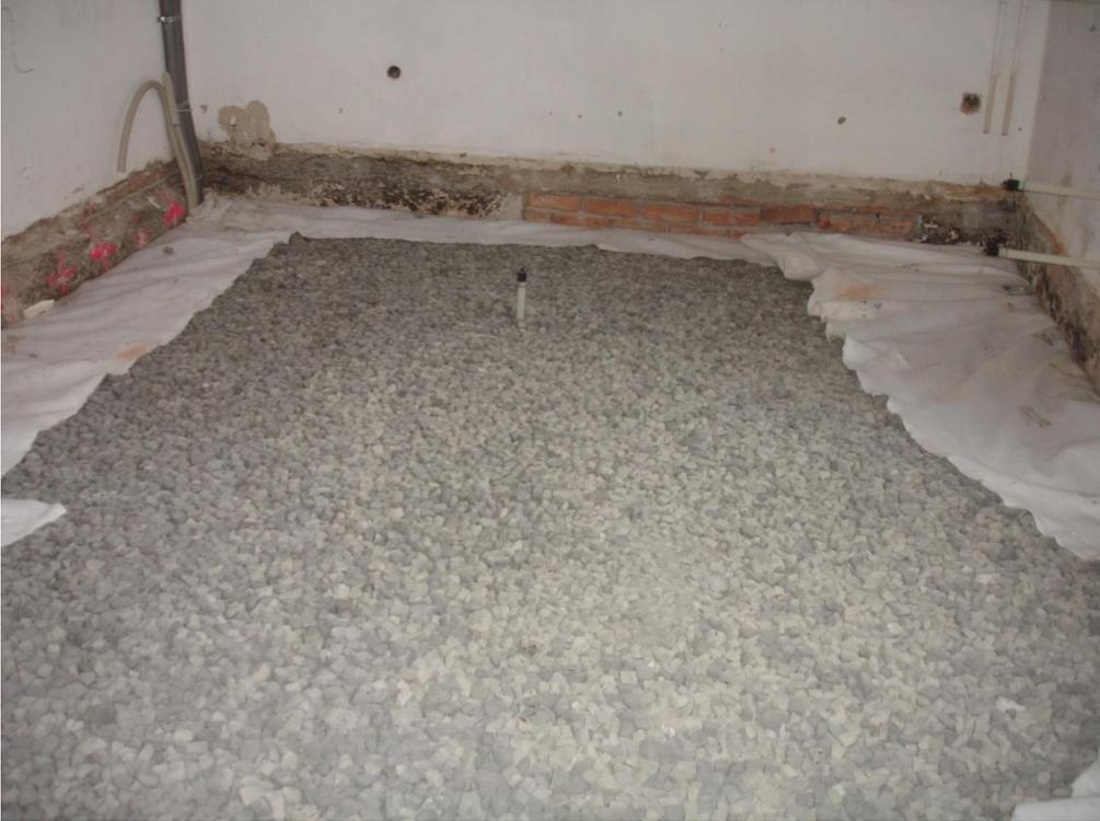
Einschlagen des überstehenden Geotextils nach Verdichtung der zweiten Lage.
